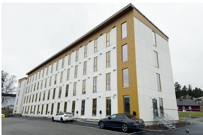
Nylig kunne Anthon Eiendom, gjennom selskapet Lahaugmoen AS, åpne det nye innkvarteringsbygget med 172 boenheter.
